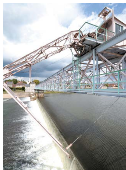
Barrage de Saint-Léger-des-Vignes (Nièvre)
