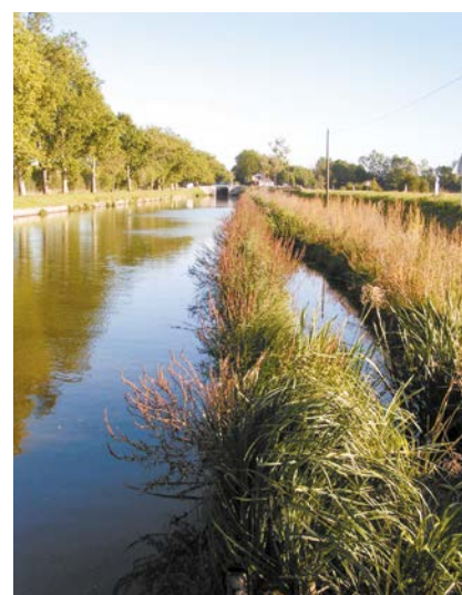
Les frayères installées le long des berges garantissent la préservation piscicole.
