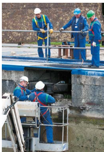
Chantier sur l'écluse de Pont Malin (Nord).
