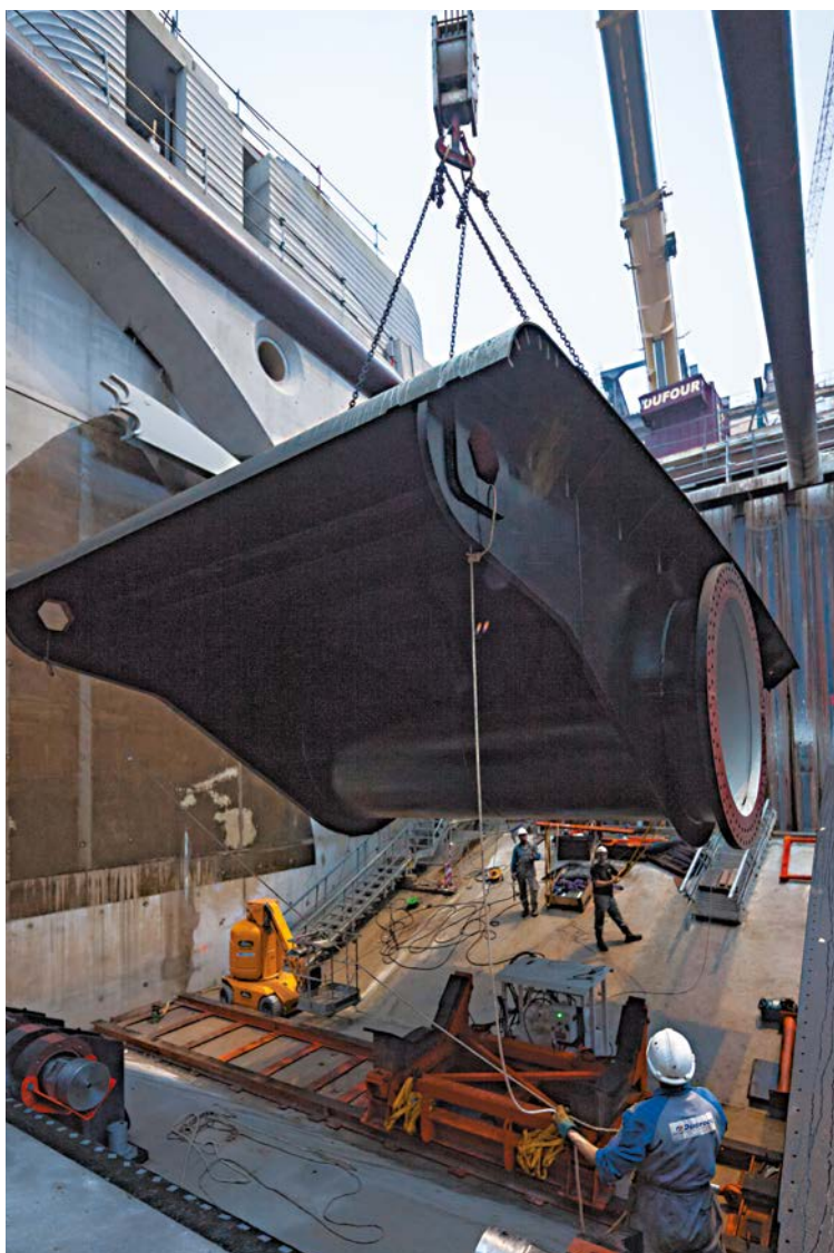
Installation d'un clapet du barrage de Chatou (Yvelines).
