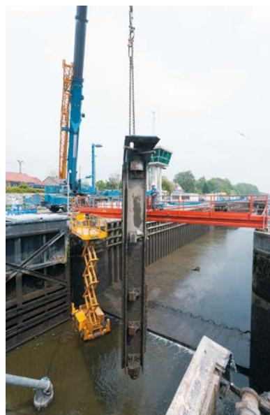
Changement d'une porte de l'écluse de Cuinchy (Pas-de-Calais) sur le canal d'Aire.
